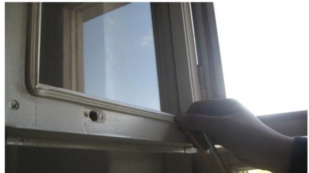
Рисунок – Самоклеющийся изоляционный материал Remontix D 100
